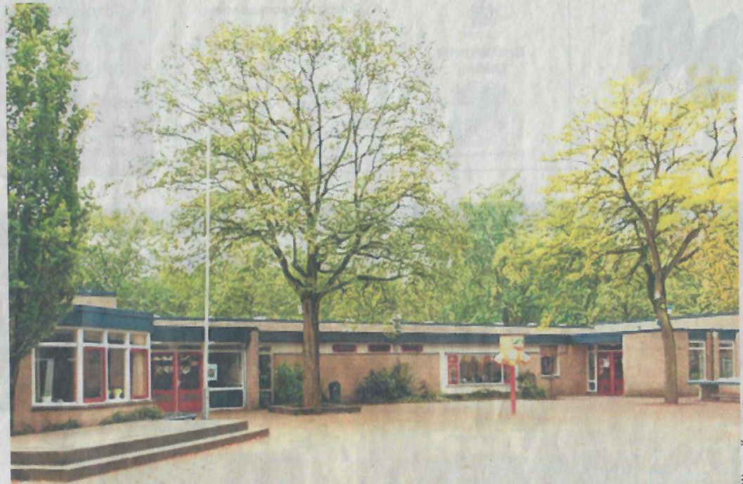
■ Het dak van de Koningin Julianaschool wordt voorzien van zonnepanelen
